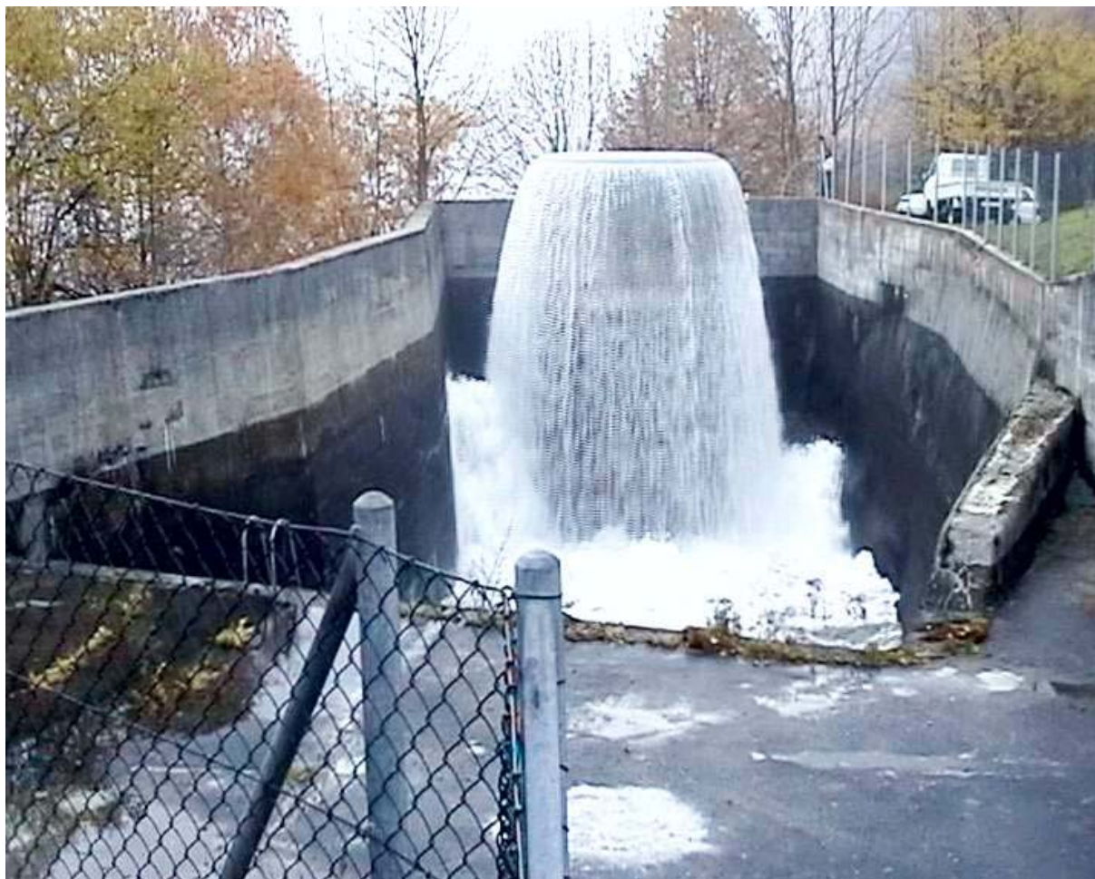
Figura 3.3: bacino superiore e pozzo verticale del pozzo piezometrico
